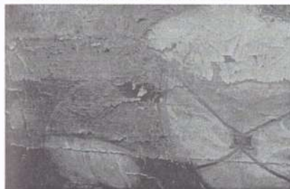
Átvételi állapot – részletfelvétel (jól láthatóak a pergések feltáskásodások, repedések és a kagylósodott felület)
