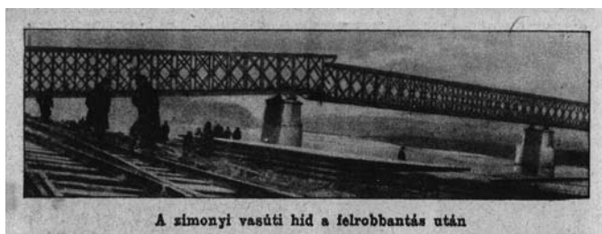
Slika 4. Srušen železnički most u Zemunu ( Vasárnapi Könyv , 1915, II, 9. sveska, str. 134).
